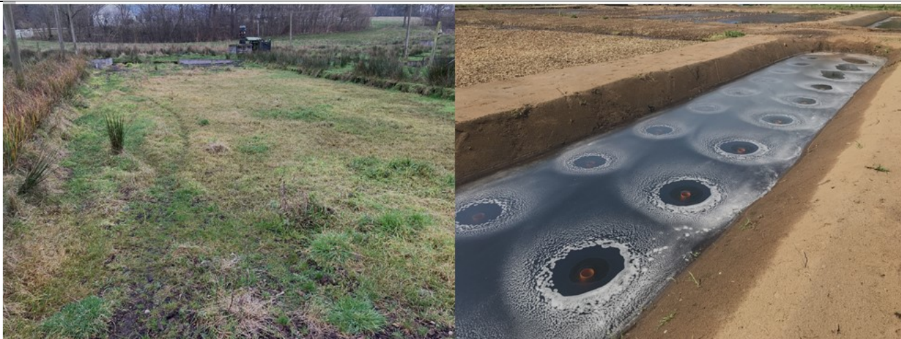
Figur: Tv: Træflisfilter Lundby Dambrug. Et af de første flisfiltre der er etableret på dambrug i Danmark, foto Lisbeth Jess Plesner Th: Træflisfilter Jødsted Mølle Dambrug. Filter lige efter etablering, foto Kaare Michelsen.
