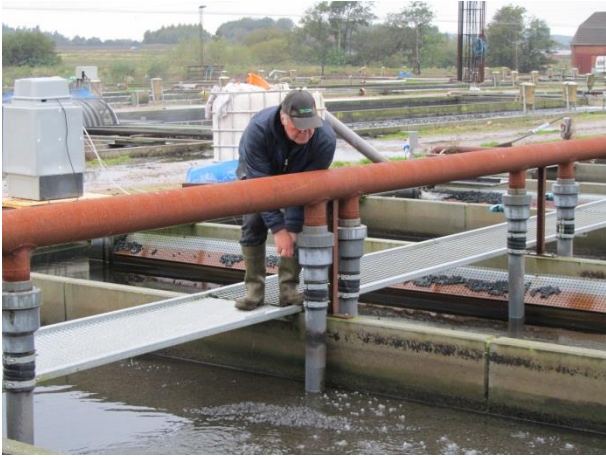
Fig. 1. Vedligehold af tromlefilter, returskylling af biofilter sektion og tilsætning af moler. Foto: L-F. Pedersen
