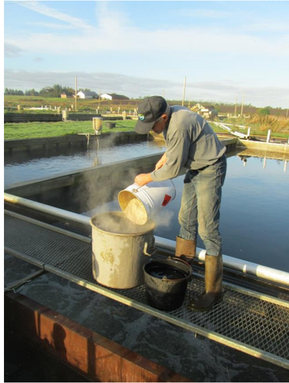
Fig. 1. Vedligehold af tromlefilter, returskylling af biofilter sektion og tilsætning af moler. Foto: L-F. Pedersen
