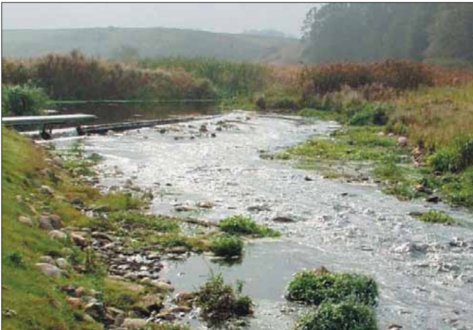
Foto: Stryg som udjævner opstemningens fald på en strækning nedenfor dambrugets vandindtag (øverst til venstre i billedet). Stryg med lave hastigheder sikrer god passage for fisk og smådyr, forudsat at passagen er tilstrækkeligt vandførende.
