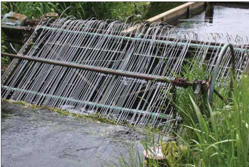
Foto: Automatisk rasterenser i indløbet på et dambrug. Typen godkendes ofte som en afgitring i indløbet. Bemærk de fleksible gitter-tråde, der bevirker, at en 10 mm tremmeafstand ikke kan overholdes, så fisk kan trænge ind bag gitteret.
