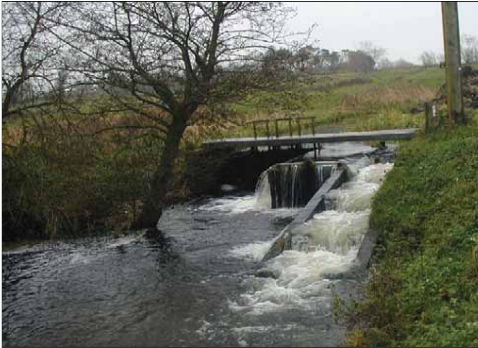
Foto: Fisketrappe af kammertypen. Indbyggede styrt vanskeliggør passage for en række fisk- og smådyrsarter. Bemærk den for fisk "forvirrende" frivandsafgivelse ved siden af fisketrappen.
