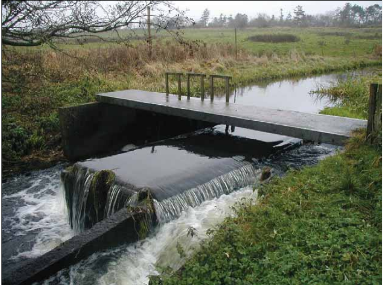
Foto: Fisketrappe af kammertypen i Binderup Å. Havørred på gydevandring skal passere spærringerne ved 4 dambrug og 2 vandmøller for at nå gydeområderne øverst i åen.
