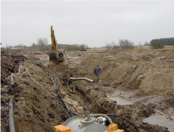
Foto: Eksempel på udgravning af dræn (Nørå Dambrug)
